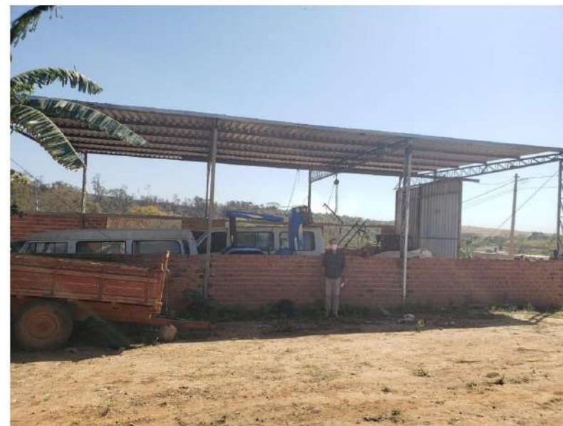
Figura 8 – Vista interna do terreno para o barracão
